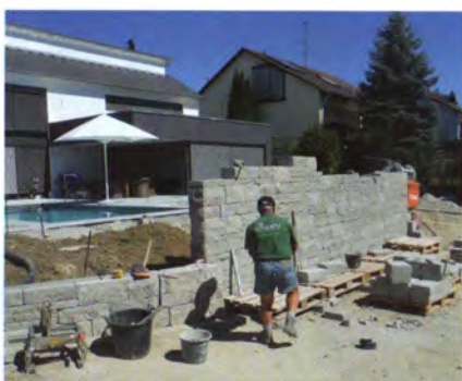
Ob Natur- oder Betonstein: Ein Wechselmauerwerk erfordert großes Können und viel Erfahrung, die hierzulande nur noch Landschaftsgärtner mitbringen.
