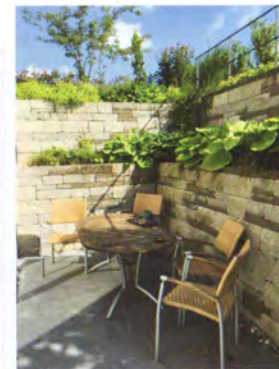
Die Santuro-Mauer kombiniert mit einem Bodenbelag aus dunkel-gelamten Granitplatten erreicht 2,50 m.
